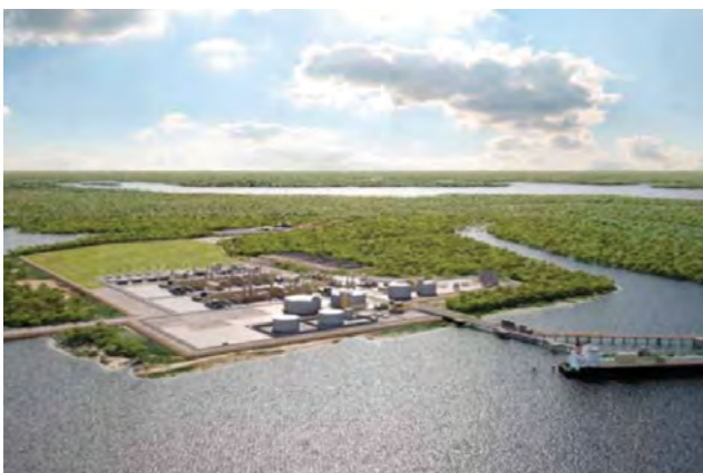
Ichthys Onshore LNG Facility - Australia
